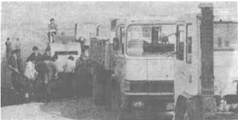
△ 我市市政施工“十佳明星企业”之一的第二市政工程公司积极开展创优、上等级活动,目前已创滨海路等省优良工程两处,完成产值1800万元,利税200万元。图为该公司在广饶县榆林路施工的场景。(刘文忠 摄)
